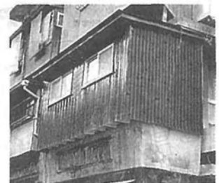
写真2: 「出し家」による増築 <変容後>
