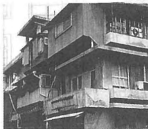
写真1: 「出し家」による増築 <変容前>
